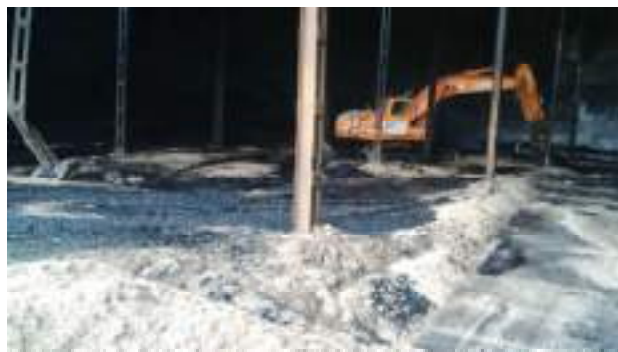
Figure 79 : photos des opérations de récupération de déchets pétroliers avec absorbants et pompage des égouts par camion hydrocureur
