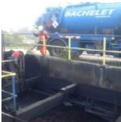
Figure 79 : photos des opérations de récupération de déchets pétroliers avec absorbants et pompage des égouts par camion hydrocureur
